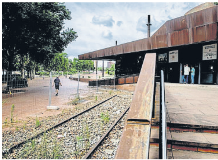
Las vías sobre las que se colocará la máquina a finales de año
